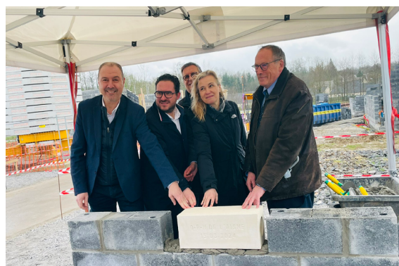
La pose d'une pierre symbolique marque le début du chantier
